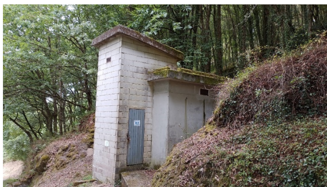
Figura 22. Depósito de Monteverde.
