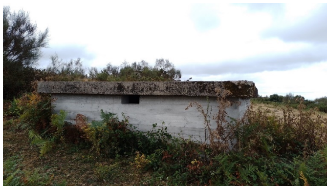
Figura 21. Depósito de Cabanas.
