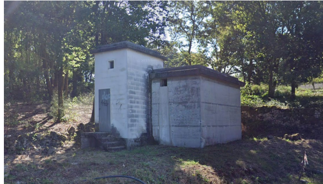
Figura 35. Depósito de Vilar de Cerreda.
