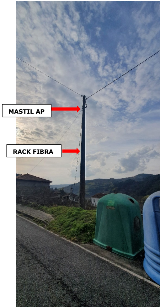
Foto 7. Emplazamiento A Carballeira
