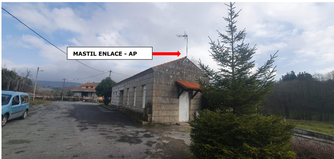
Foto 8. Loñoa do Monte (Rack Interior)
